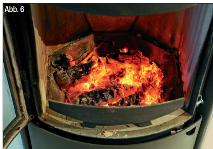
Lassen Sie diese Holzaufgabe mit auf "AUF" stehender Primär- und Sekundärluft herunterbrennen, bis kaum noch Flammen vorhanden sind und das Holz in die Glutphase übergeht (Abb. 6). Je nach Holzgüte, Schornsteinzug und Witterung dauert diese Verbrennungsphase unterschiedlich lange.
