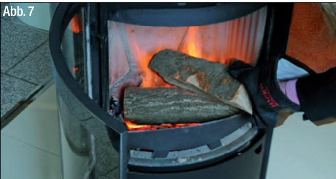
Sind auch diese Holzscheite rundherum angebrannt, sollten Feuerstätte und Abgassystem weitgehend die Betriebstemperatur erreicht haben. Jetzt können Sie die Primärluft-Einstelleinrichtung (rechts) auf "ZU" stellen (Abb. 8) und die Verbrennung hauptsächlich über die Sekundärluft-Einstelleinrichtung (links) regeln. Beim Feuern von Holz soll nach Erreichen der Betriebstemperatur hauptsächlich mit Sekundärluft geheizt werden (Primärluft in eine niedrige Stellung).
