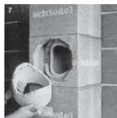
7 Alle Schamotteteile anfeuchten, anschließend Fugenmasse auf Rauchrohr- bzw. Putztürzarge auftragen u. auf Schamottrohr festdrücken.
