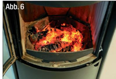
Lassen Sie diese Holzauflage mit auf "AUF" stehender Primärluft herunterbrennen, bis kaum noch Flammen vorhanden sind und das Holz in die Glutphase übergeht (Abb. 6). Je nach Holzgüte, Schornsteinzug und Witterung dauert diese
