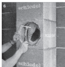
6 Schamotteteile vorsichtig entfernen.
