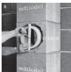
8 Mit Draht Zarge am Innenrohr anpressen und ausquellenden Kitt verstreichen.
