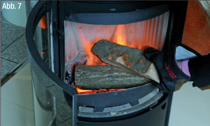
Sind auch diese Holzscheite rundherum angebrannt, sollten Feuerstätte und Abgassystem weitgehend die Betriebstemperatur erreicht haben. Jetzt können Sie die Primärluft-Einstelleinrichtung auf "ZU" stellen (Abb. 8) und die Verbrennung hauptsächlich über die Sekundärluft-Einstelleinrichtung regeln. Beim Feuern von Holz soll nach Erreichen der Betriebstemperatur hauptsächlich mit Sekundärluft geheizt werden (Primärluft in eine niedrige Stellung).
